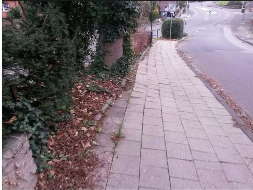
Bild 3: Beschädigung Gehweg durch Wurzeln
