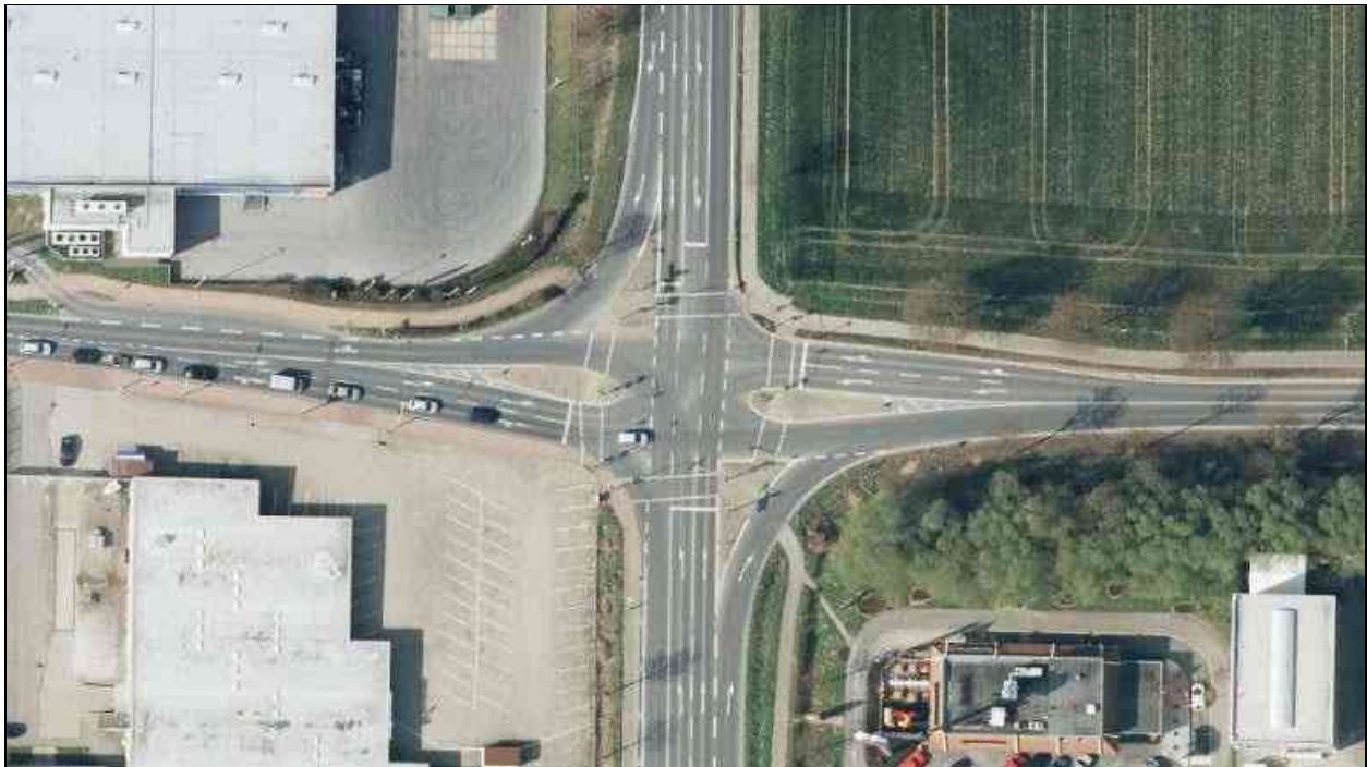
Abbildung 4: Knotenpunkt Friedrich-Ebert-Straße (L225) / Roermonder Straße (L 164) [Luftbild: TIM-online]
