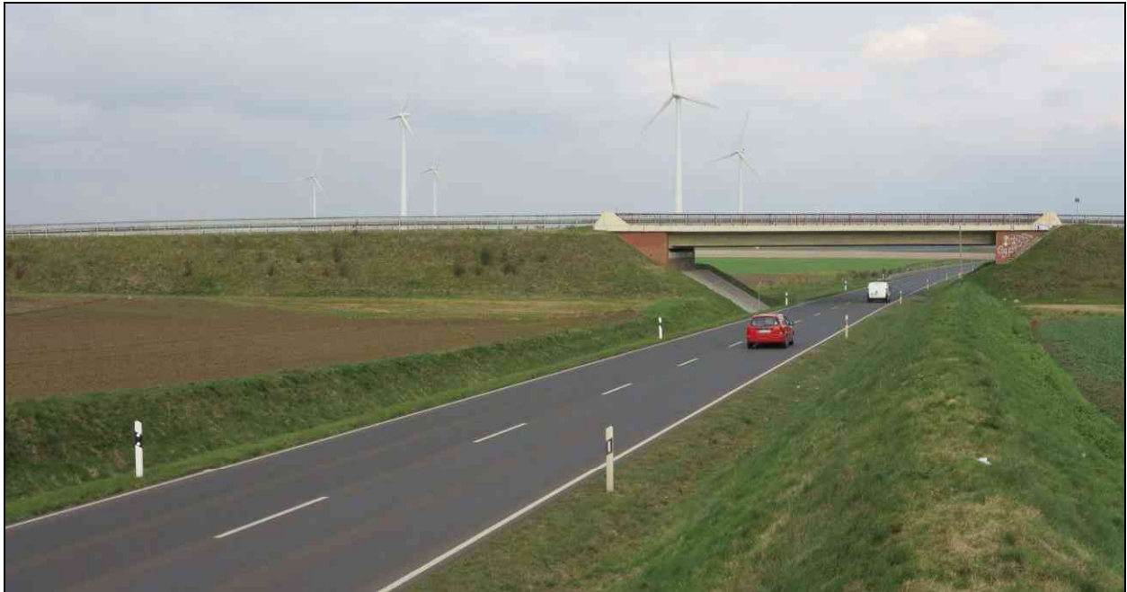
Abbildung 3: B57n nördlich des Knotenpunktes mit der L 225, Blickrichtung Nord
