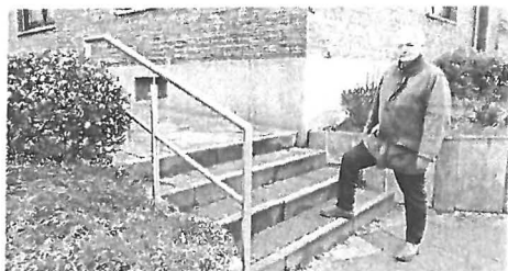
Karl-Alexander Iskam kritisiert den Handlauf an der Treppe in Frelenberg. Er meint, der Lauf hätte in der Mitte montiert werden müssen. FOTO: M.-C. ZEIDLER
