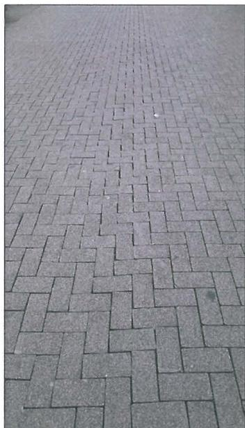
**Abb. 1: Betonsteinpflasteroberfläche mit Torsionsschäden**
