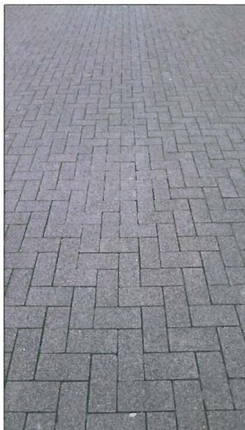
**Abb. 2: Betonsteinpflasteroberfläche ohne Torsionsschäden (zum Vergleich)**
