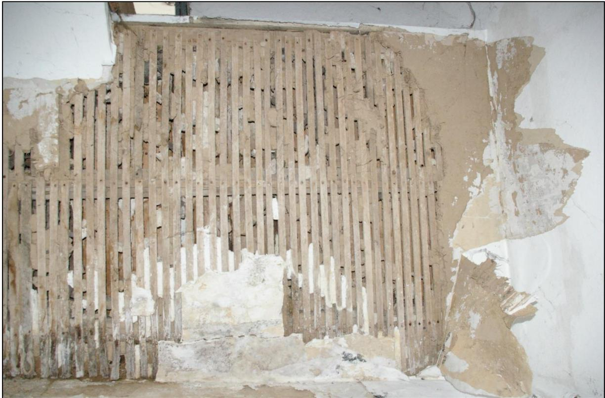
Abbildung 10: Abgelöste Tapete und Putz an der Decke im 1. OG, Aufnahme vom 30.05.2018
