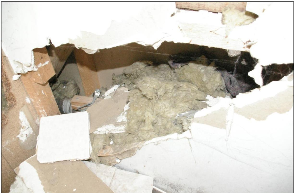
Abbildung 103: Beschädigte Verkleidung im 2. OG, Aufnahme vom 30.05.2018
