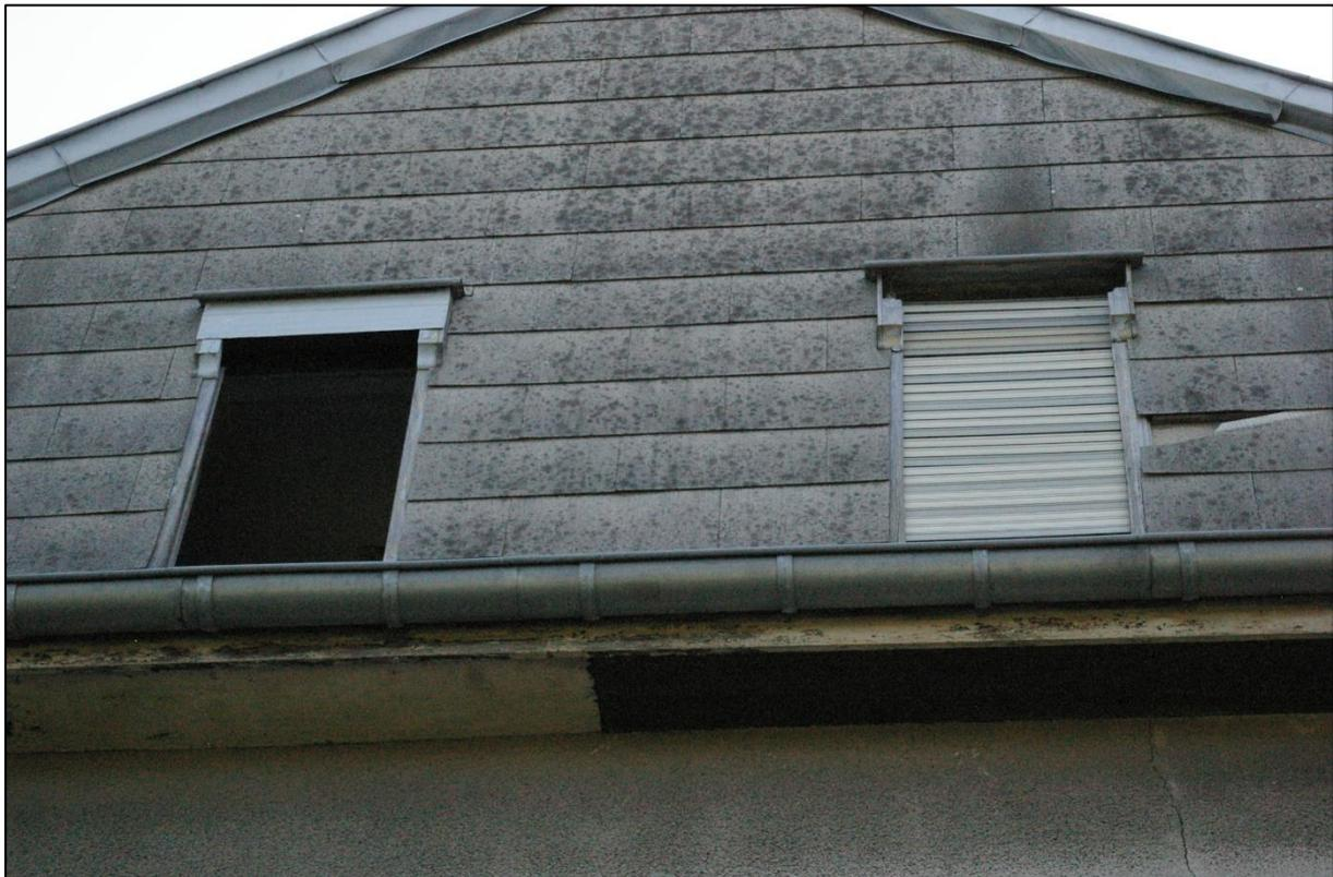
Abbildung 16: Fassade Hausnr. 20 mit beschädigten Asbestplatten neben dem rechten Fenster, Aufnahme vom 30.05.2018
